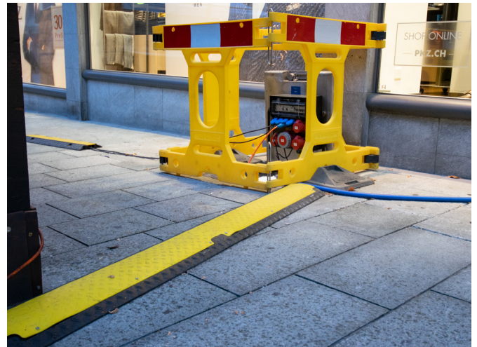
Pont de câble SMART
